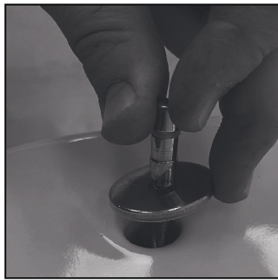
03 Avvitare il fissaggio tenendolo sollevato ma non bloccare. Tighten the fixing screw by keeping it lifted but do not block it.
