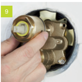
9 Монтаж функционального элемента.
