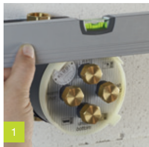
1 Установка встраиваемого элемента.
