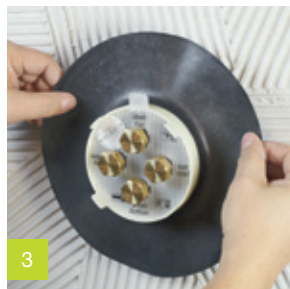
3 Нанесение штукатурки и приклеивание уплотнительной манжеты.
